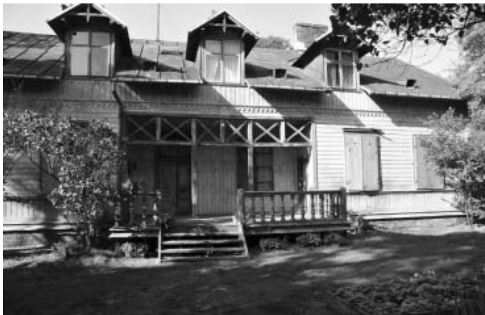
Willa „Batorówka” przy ulicy Rzeźbiarskiej 14, widok od podwórka, fot. H. Solnicki, Oddział Anin TPW
