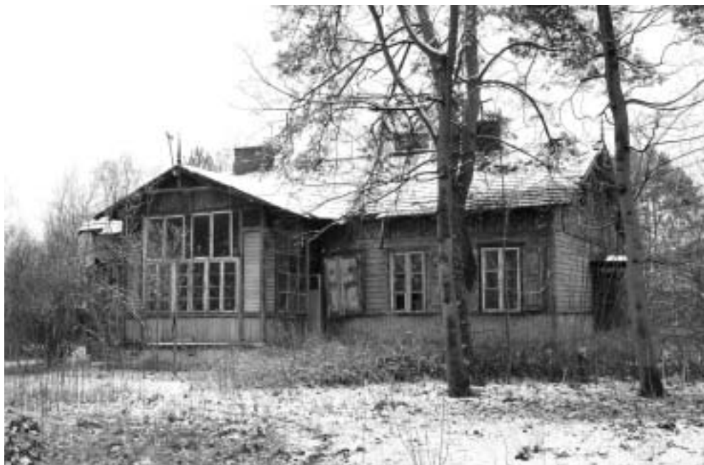
Willa „Zofiówka” przy ulicy XII Poprzecznej 6, wybudowana we wczesnych latach 30. XX w., rozebrana w 2010 r., fot. H. Solnicki, Oddział Anin TPW
