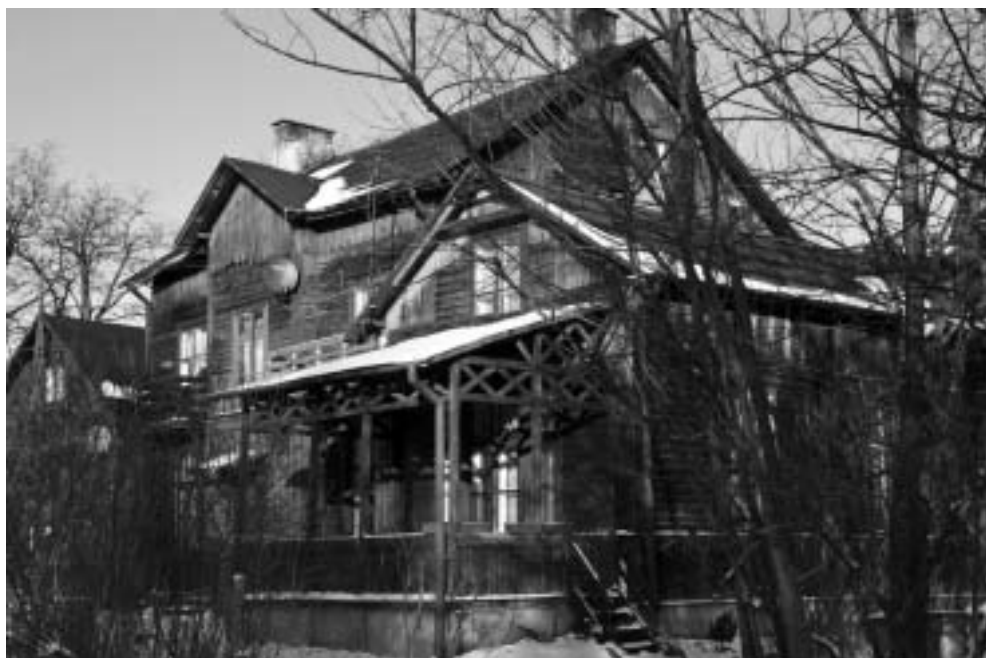
Willa przy ulicy Rzeźbiarskiej 10, wybudowana na początku ubiegłego wieku, dobrze utrzymana, współcześnie zamieszkuje w niej wiele osób, fot. H. Solnicki, Oddział Anin TPW
