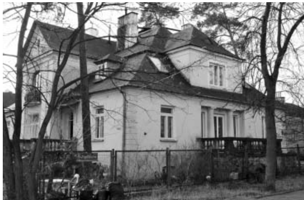
Willa przy ulicy IV Poprzecznej 20, budynek wielorodzinny zbudowany na przełomie lat 20. i 30. XX w., obecnie pod zarządem komunalnym, fot. H. Solnicki, Oddział Anin TPW
