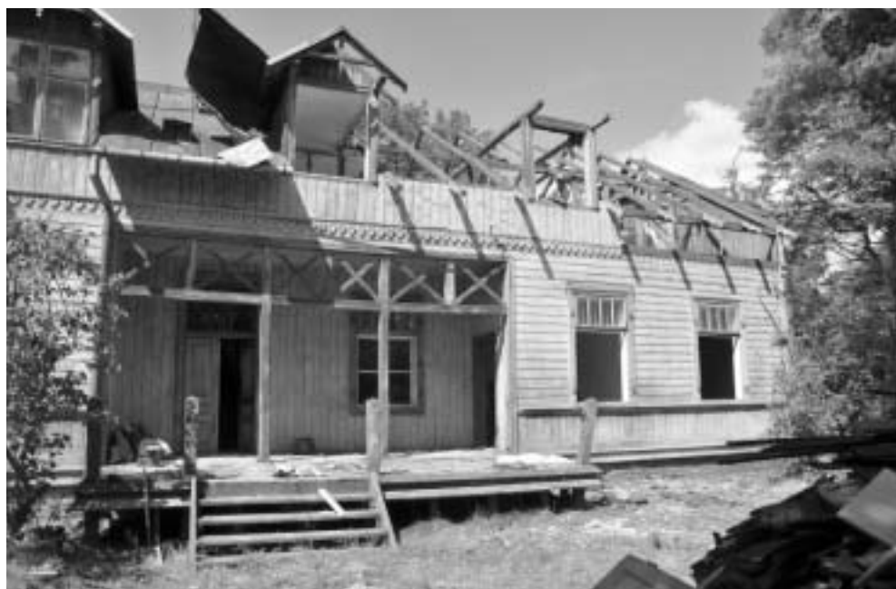
Willa „Batorówka” przy ulicy Rzeźbiarskiej 14 w trakcie rozbiórki w czerwcu 2010 r., dom ma zostać złożony we wsi Mężenin nad Bugiem, fot. H. Solnicki, Oddział Anin TPW
