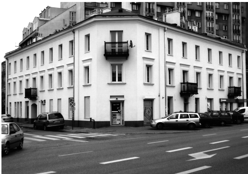
6. Kamienica przy ul. Skaryszewskiej 2 po rekonstrukcji pierwotnego wystroju elewacji, stan z października 2009 r. Fot. J. Sujewski
