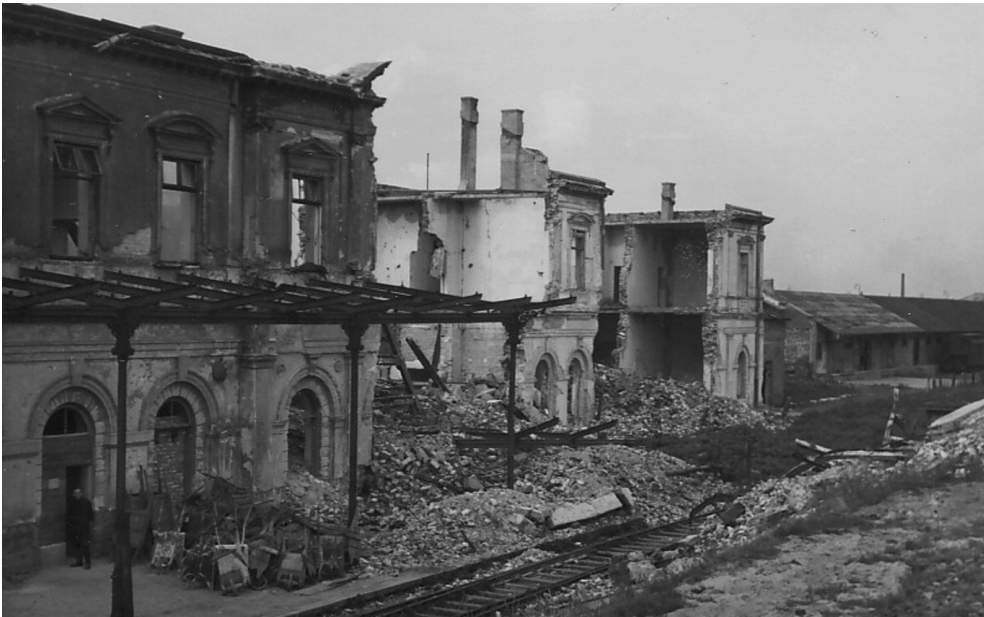
Widok od strony torów, 1945 r., fot. ze zbiorów Jacka Rutkowskiego
