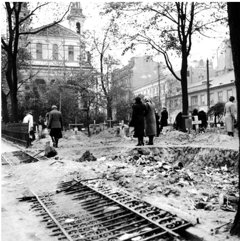
Ul. Chłodna, kościół św. Karola Boromeusza, przed kościołem groby, zniszczone ogrodzenie
