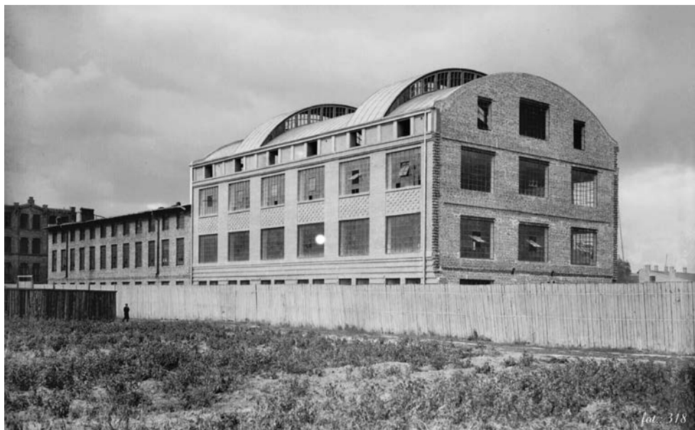
Budynki Fabryki przy ul. Kałuszyńskiej
