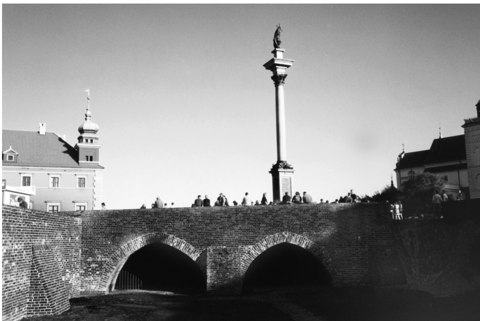
Zrekonstruowany Most Gotycki na placu Zamkowym
