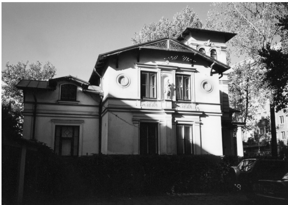
Uratowana od rozbiórki „willa Struwego” przy ul. Pięknej 44a
