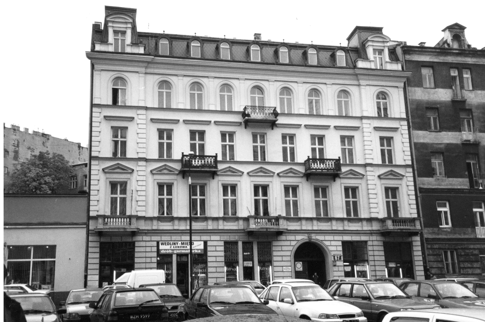
Uratowana od rozbiórki kamienica przy ul. Koszykowej 67
