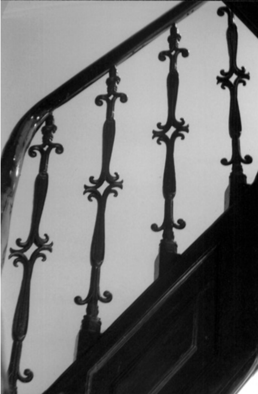
5. Balustrada schodów w kamienicy Lucińskiego przy pl. Trzech Krzyży 3 (1871) ze wspornikami żeliwnymi identycznymi, jak zastosowane w budynku przy ul. Kijowskiej 5, fot. J. Sujecki
