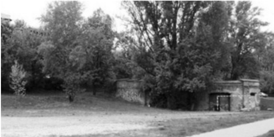
48. Dynasy – stan obecny, widok terenu i ruin budynku rotundy od strony południowej
