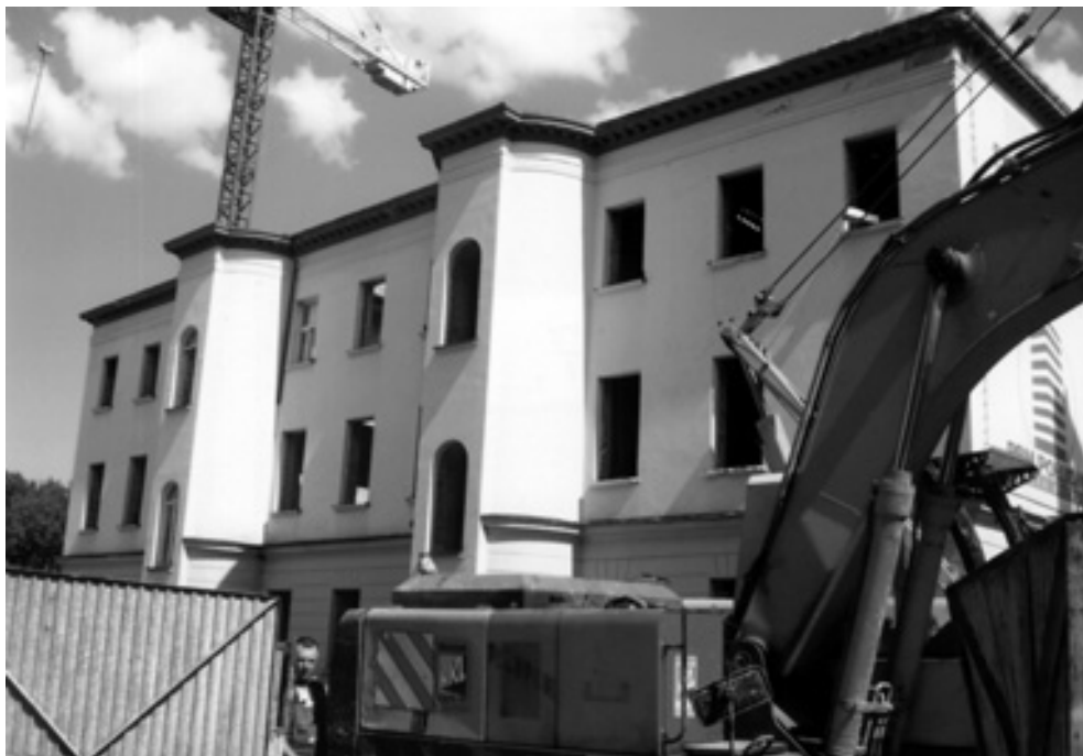
7. Budynek przy ul. Kijowskiej 5 podczas remontu, lipiec 2010, fot. J. Sujecki
