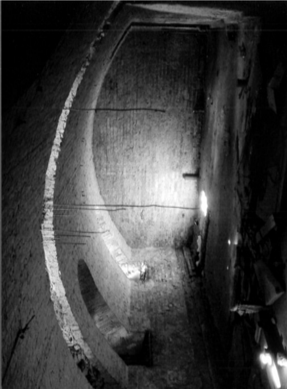
6. Ul. Kijowska 5 – piwnica z kolebkowymi sklepieniami, 2009, fot. J. Sujeci
