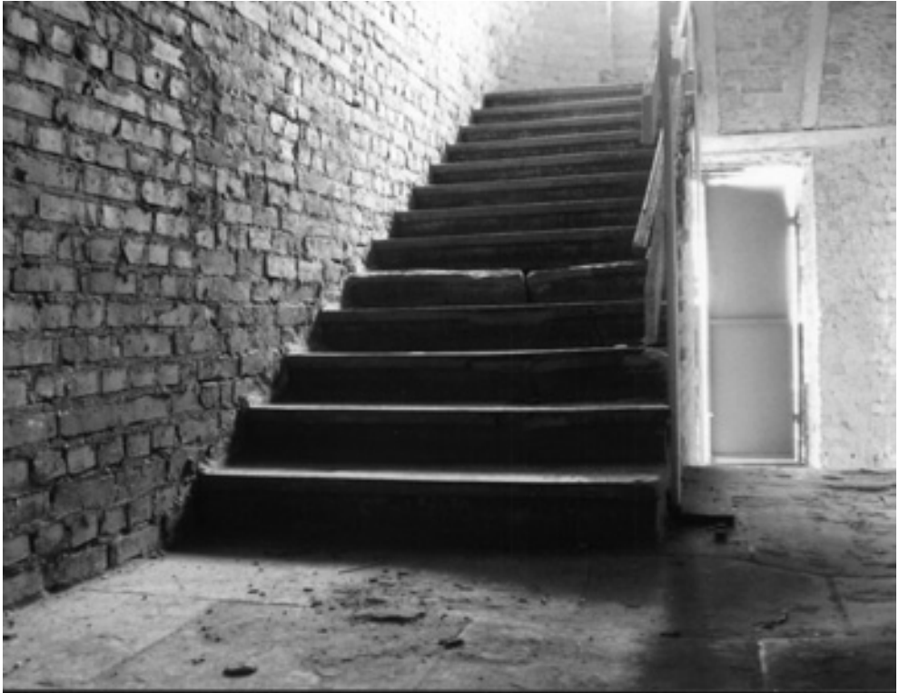
3. Kamienne schody z 1869 r. zachowane w zachodniej klatce schodowej, fot. J. Stujecki
