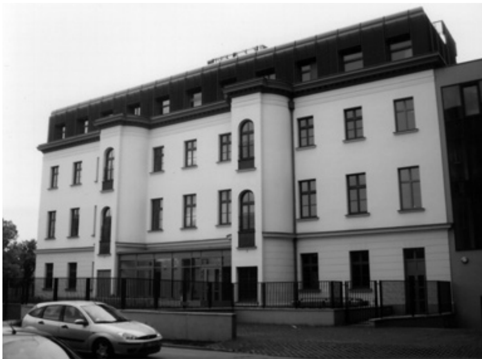
8. Ul. Kijowska 5 – północna elewacja budynku po zakończeniu remontu i prac adaptacyjnych, maj 2013, fot. J. Sujecki
