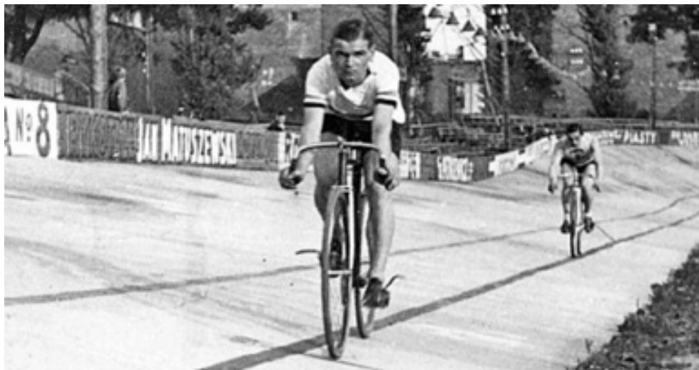
32. Tor kolarski WTC z nawierzchnią betonową, połowa lat 30. XX w. (ze zbiorów Fundacji Ośrodka Karta)
