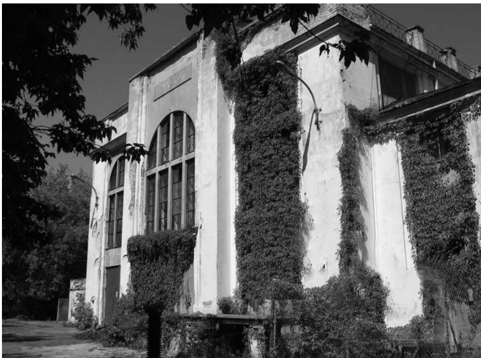
Budynek elektrowni z 1931 r., widok współczesny. Fot. ze zbiorów Zbigniewa Wizimirskiego
