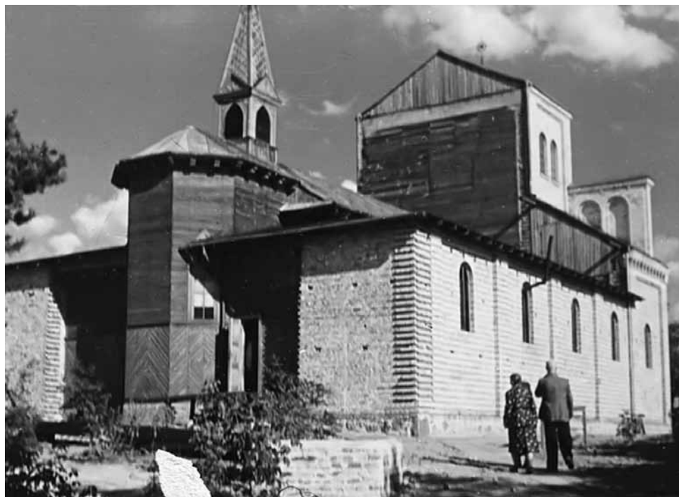
Wznoszenie murowanego kościoła, lata 50. XX w. Fot. z archiwum rodzinnego Jana Marcinkiewicza
