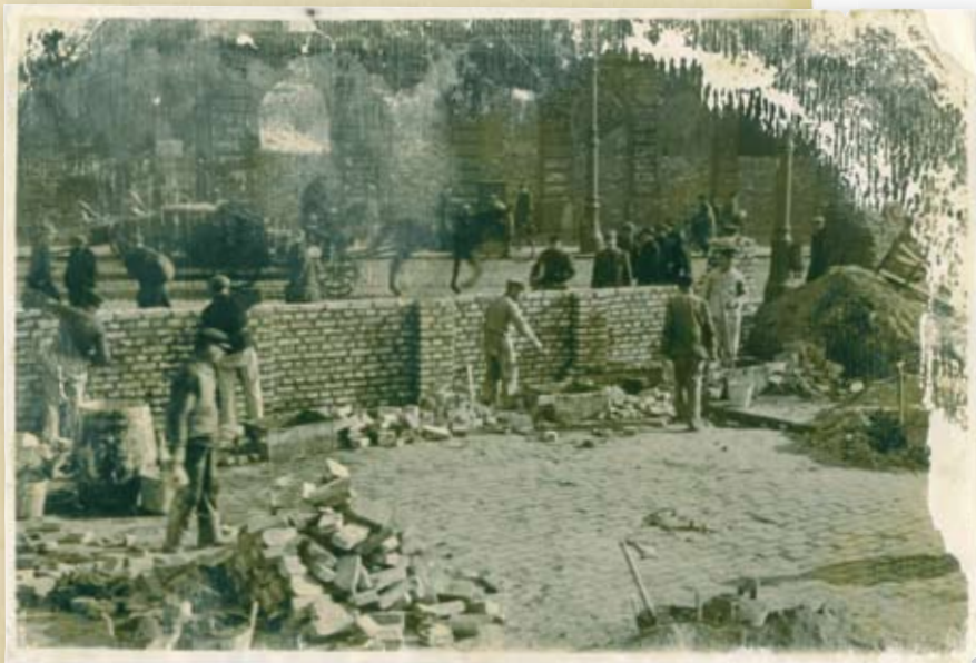
Budowa muru getta przy ulicy Grzybowskiej
