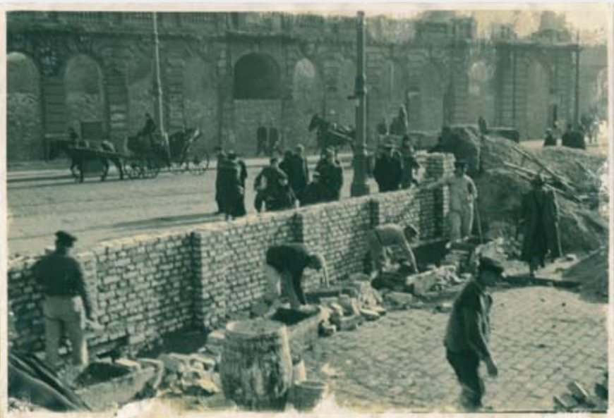
Budowa muru getta przy ulicy Grzybowskiej
