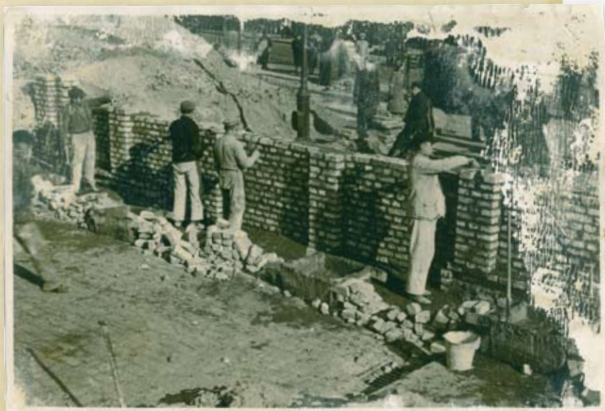
Budowa muru getta przy ulicy Grzybowskiej
