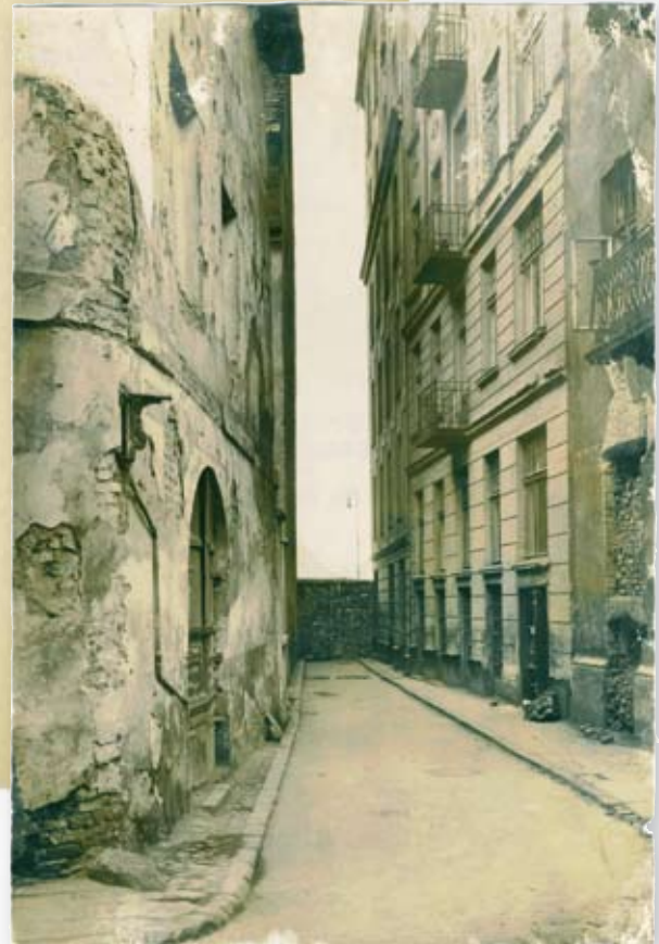
Mur getta wybudowany przy ulicy Koźlej przy wylocie na ulicę Freta
