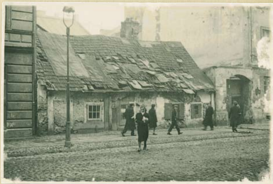
Getto – zniszczony parterowy budynek
