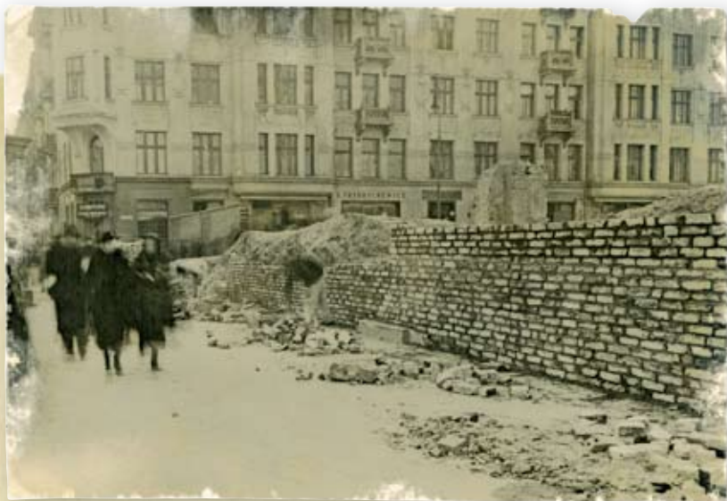
Budowa muru getta w poprzek ulicy Siennej oraz budowa muru zabezpieczającego ruiny budynku przy ulicy Zielnej
