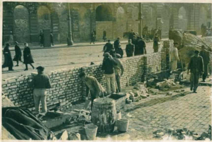
Budowa muru getta przy ulicy Grzybowskiej
