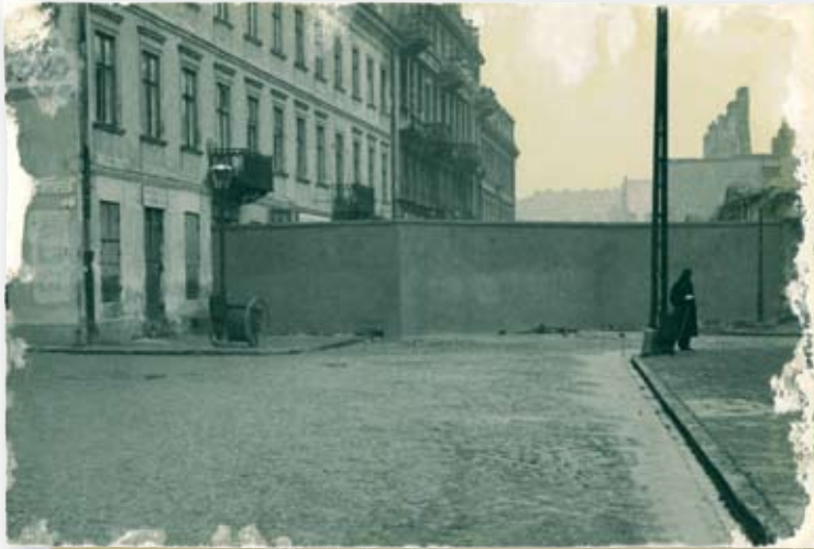
Mur getta przy ulicy Mirowskiej
