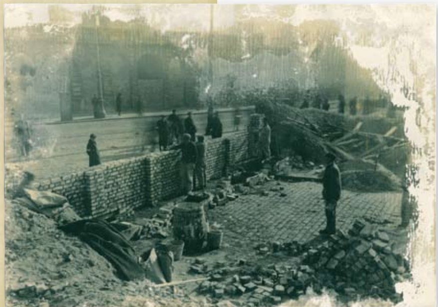
Budowa muru getta przy ulicy Grzybowskiej
