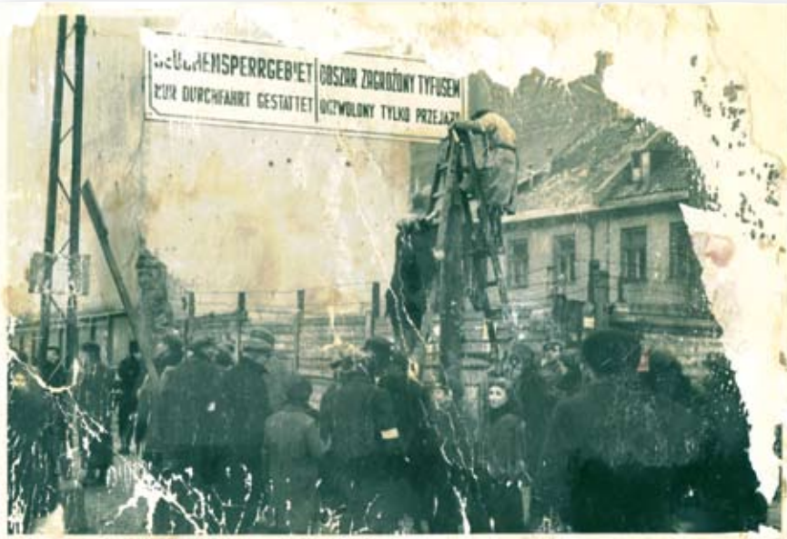
Ul. Solna – tablica informująca o zagrożeniu tyfusem umieszczona na bramie wjazdowej na teren przyszłego getta
