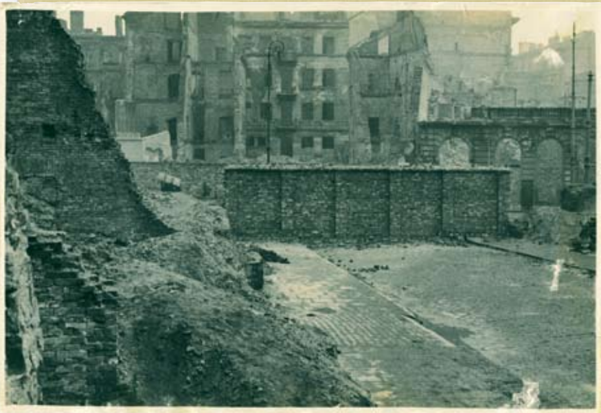
Budowa muru getta przy ulicy Grzybowskiej
