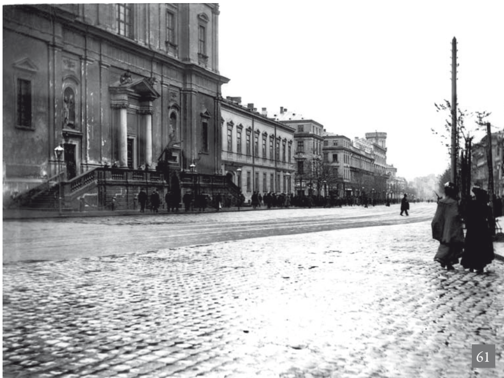
61 Widok w kierunku placu Zamkowego, po stronie lewej fragment fasady kościoła św. Krzyża, przed 1910 r. View towards Zamkowy Square with a fragment of the facade of the Church of the Holy Cross on the left, prior to 1910.
