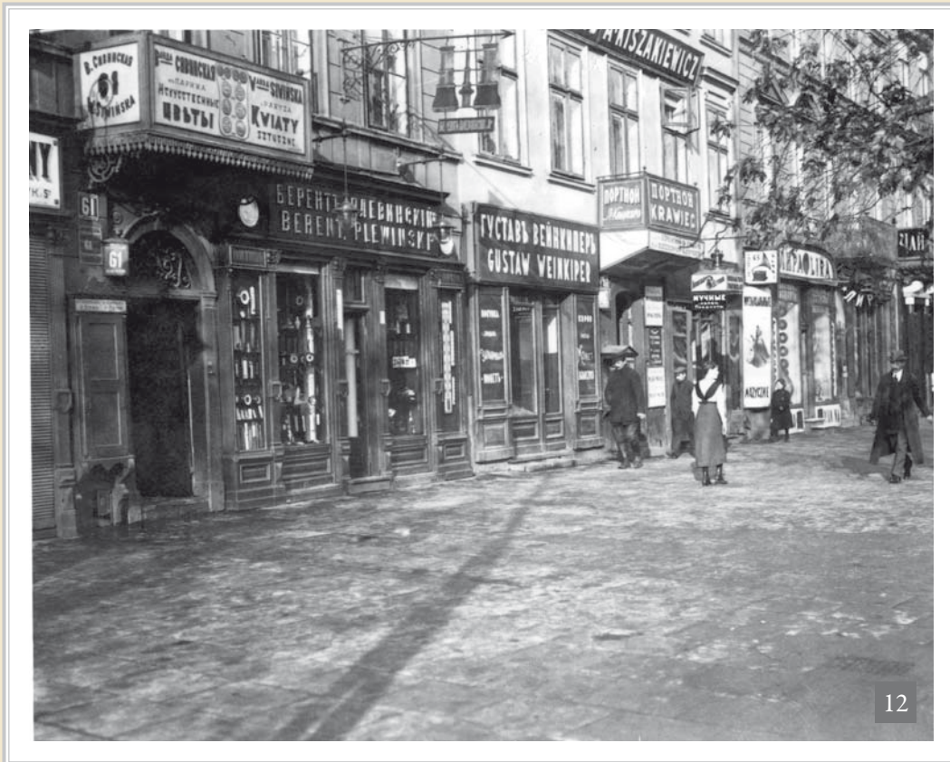
12 Witryny sklepowe w kamienicach o numerach 61, 63, 65, przed 1915 r. Store displays in the No. 61, No. 63, and No. 65 tenement houses, prior to 1915.
